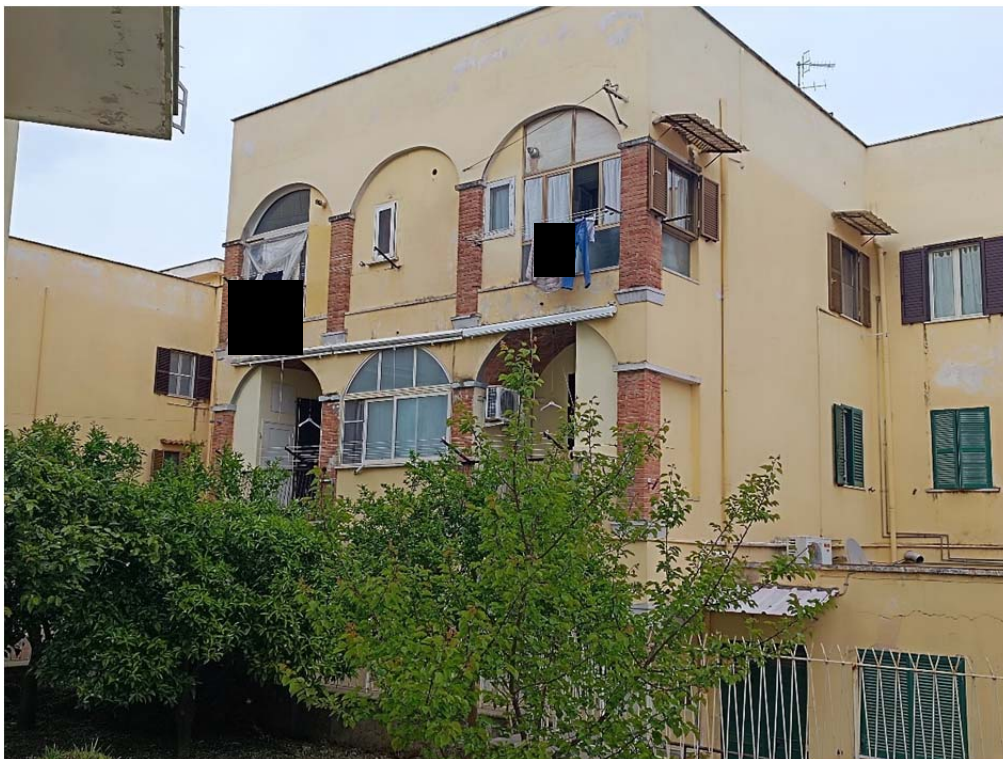
Foto della Facciata su vico IV Lungomare G. Caboto, Piano 1 - (Lato Sud e Ovest) Ripostigli ricadenti sui due balconi a dx e sx della vetrata centrale
